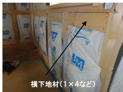
断熱材(グラスウール厚さ90mm)
