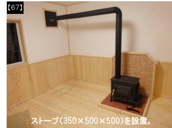
2×4材でレンガが収まる枠を作り、下側にスレートを取付けレンガをならべます。(約900×800)
