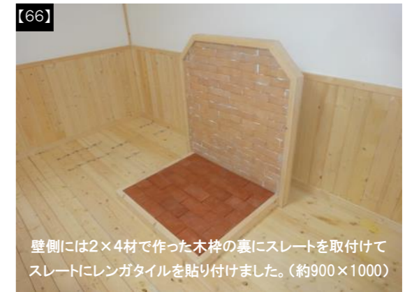
2×4材でレンガが収まる枠を作り、下側にスレートを取付けレンガをならべます。(約900×800)
