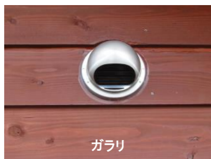
換気口、換気用パイプ(100φ)
